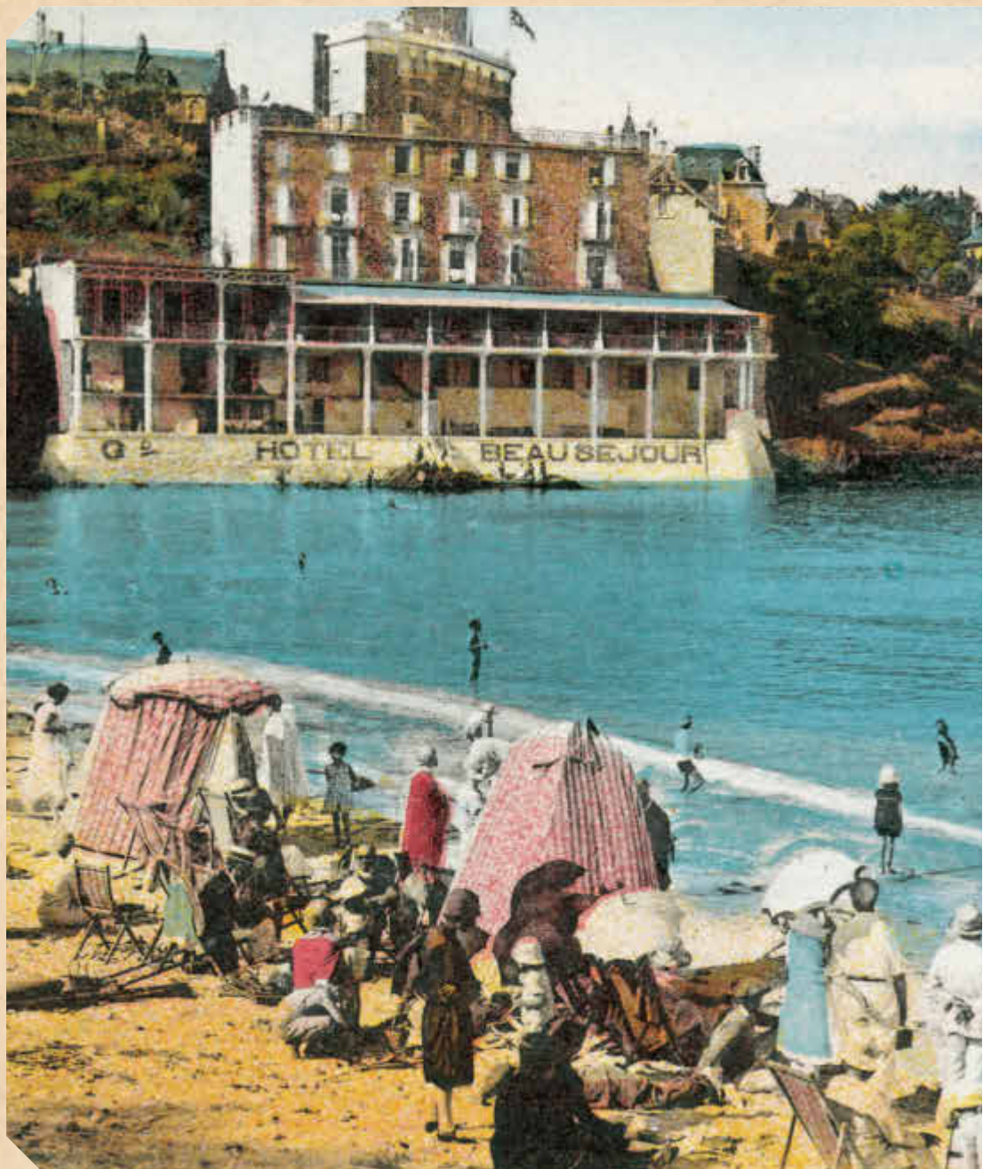
Édifié à flanc de rochers, l'hôtel Beauséjour surplombe la plage qui est au cœur de Saint-Cast. En 1883, Alfred Marinier, peintre parisien amoureux du site, acheta les terrains disponibles, y fit planter des arbres et incita ses amis à y construire chalets et villas. Une station balnéaire était née.
